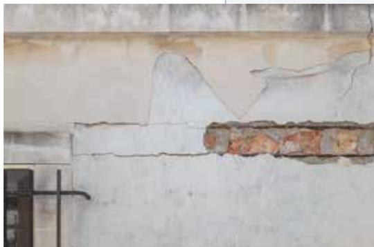
Fig. 3 - Fissuration consécutive à la corrosion des armatures (maison individuelle).
