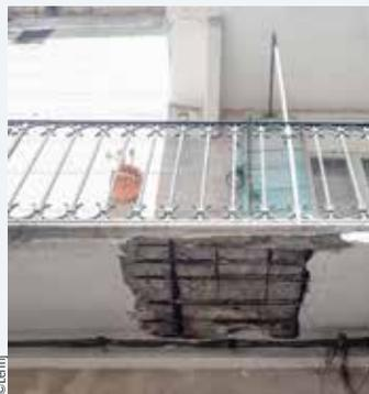
Fig. 4 - Epaufrement laissant apparaître les armatures corrodées (sous-face d'un balcon).
